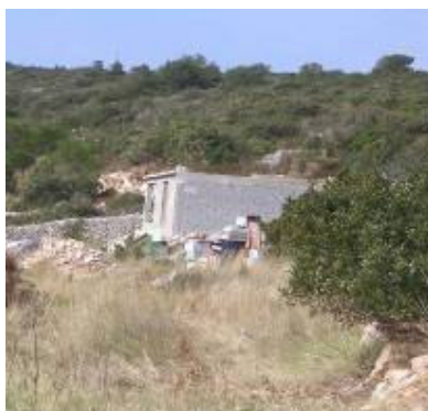
Bespravna gradnja na Visu
