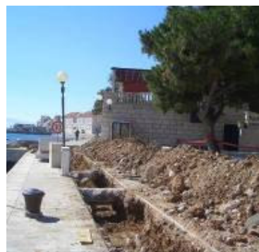
Kanalizacijski kolektori na Braču
